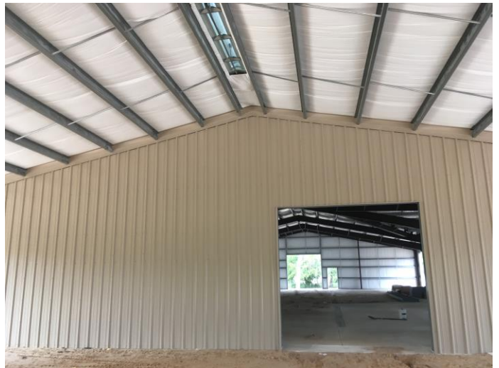
4. PEMB dividing wall
